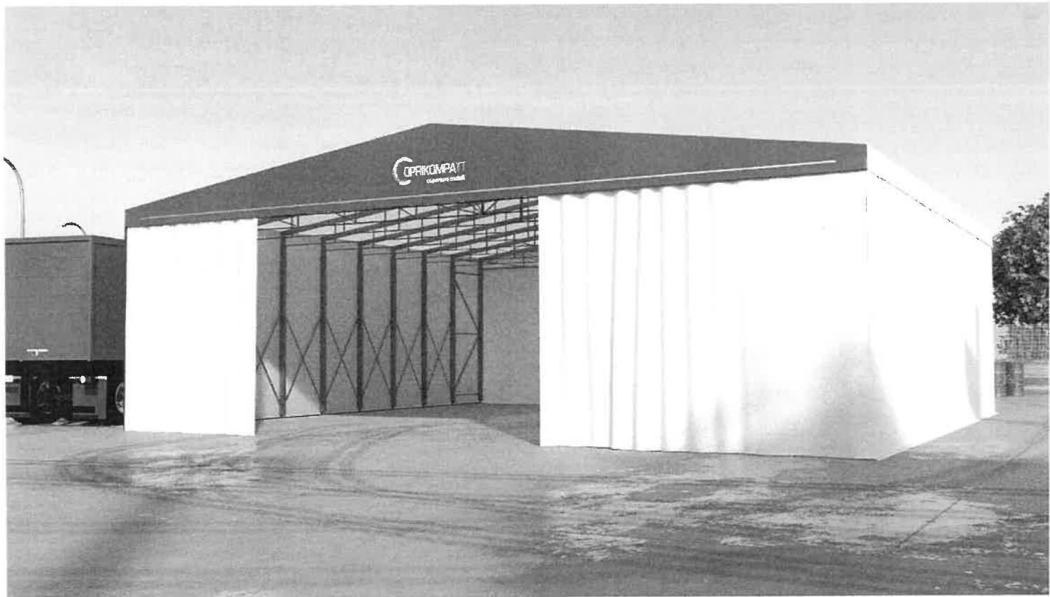
La tendo copertura **COPRITUTTO®**, modello standard, è una struttura autoportante retraiabile composta da coppie di montanti sopra i quali sono fissate delle capriate a traliccio attraverso piastre imbullonate con bulloneria di tipo 8.8 e dadi. I montanti si
