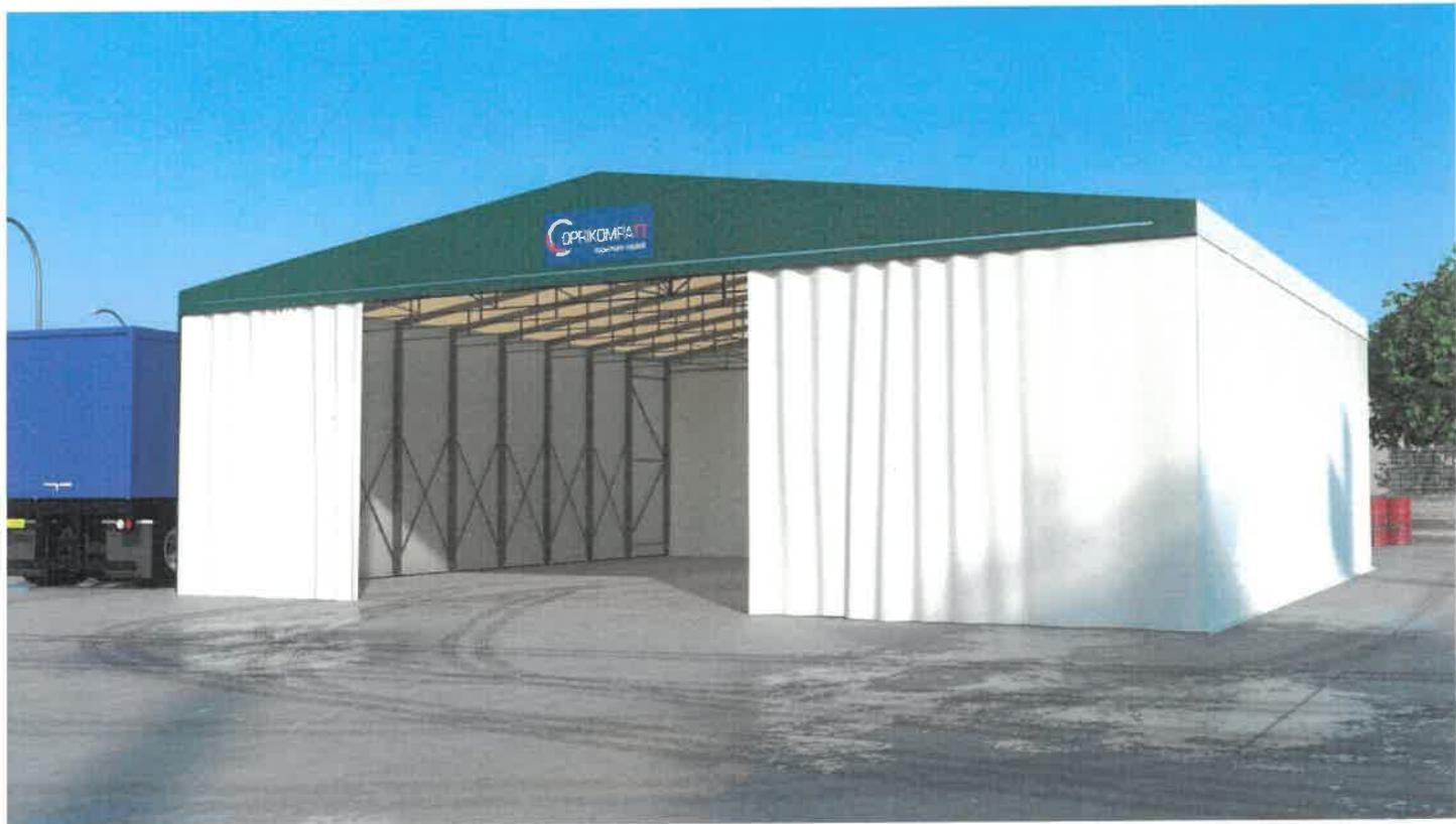
La tendo copertura **COPRITUTTO®**, modello standard, è una struttura autoportante retraibile composta da coppie di montanti**COPRIKOMPATT S.r.l.**
